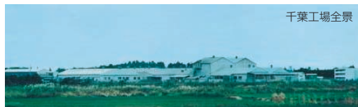
千葉工場全景
